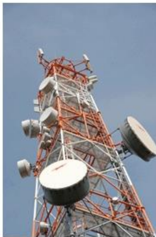
3.13. Směrové paraboly
